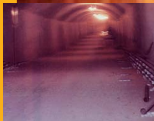
Ligne Métro N°2, Tronçon La-Savane / Du-Collège
